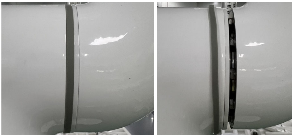
图 3-4：拆橡胶固定环
