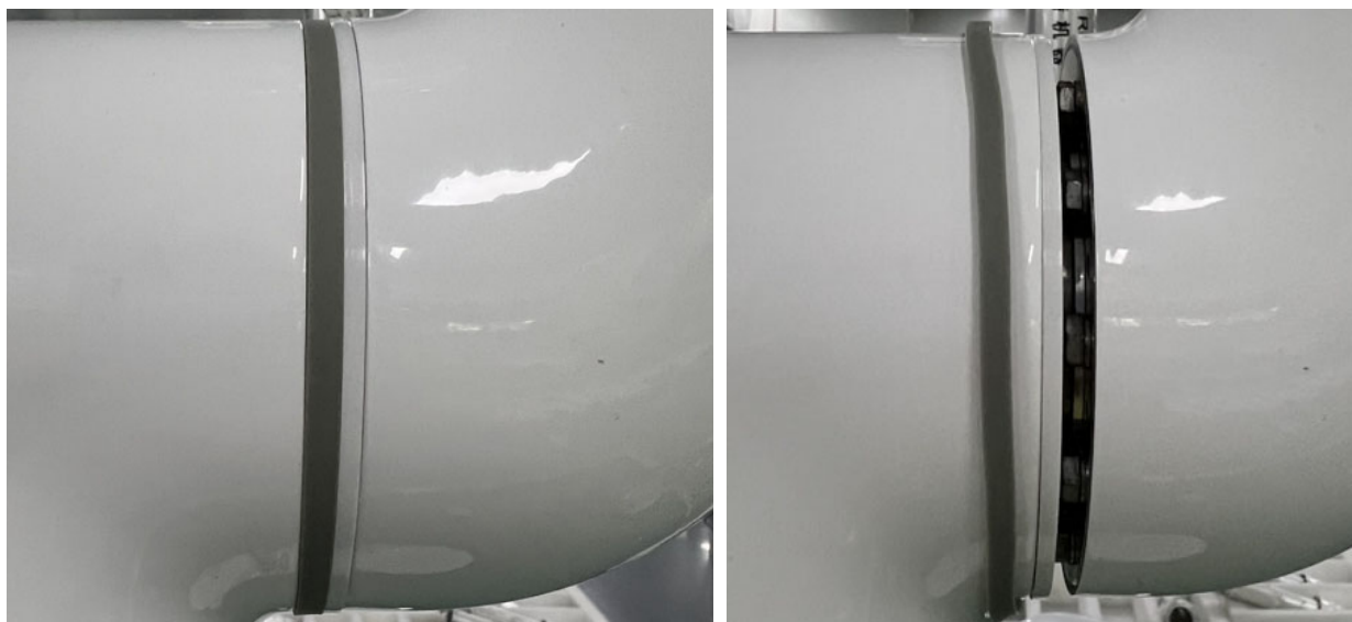
图 3-4：拆橡胶固定环
